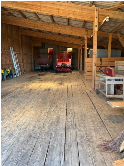
Anbau Wagenshopf (auf Schweinestall)
