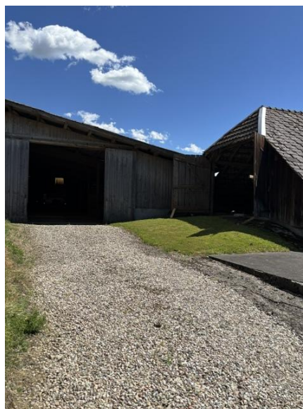
Zufahrt alte Scheune und Wagenshopf
