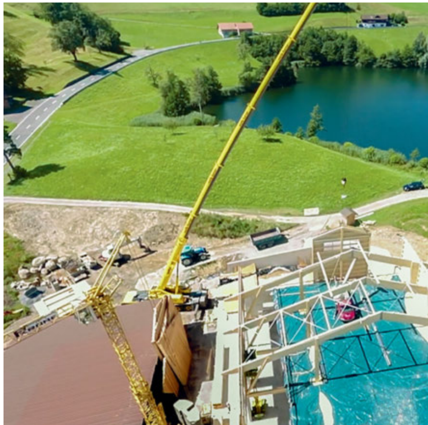
Kantone und Gemeinden haben die Gewässerräume rechtsverbindlich auszuscheiden, wobei die Bauabstände je nach Gewässergrösse unterschiedlich festgelegt werden können. Drohnenaufnahme: System Wolf AG
