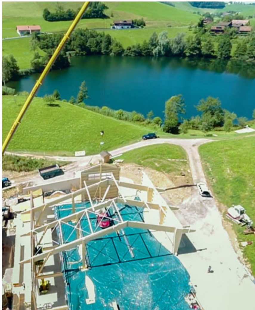
Les cantons et les communes peuvent fixer les distances de construction individuellement via une délimitation à caractère contraignant des espaces réservés aux eaux. Photo prise à l'aide d'un drone: System Wolf AG
