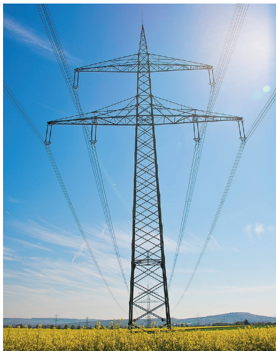
Für die Entschädigung für den Bau eines Strommastes, ist das Potenzial des Standorts ausschlaggebend. (Bild: Pixabay)
