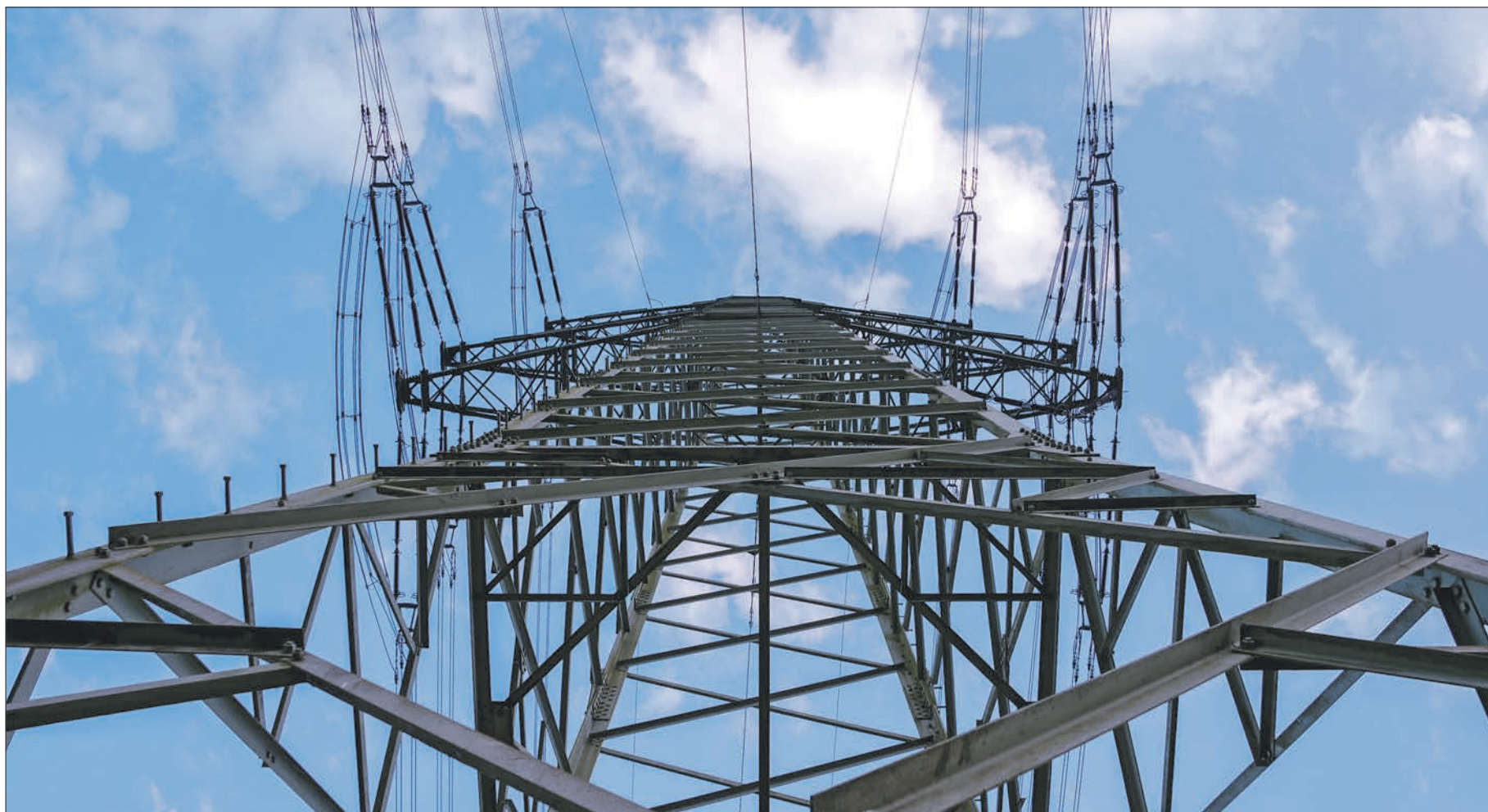
Seit dem 1. Januar 2016 gelten neue Entschädigungsansätze für Masten, Schächte und Leitungen. Sie beruhen auf einer Abgeltung des Schadens auf landwirtschaftlichem Land. (Bild Pixellio)
