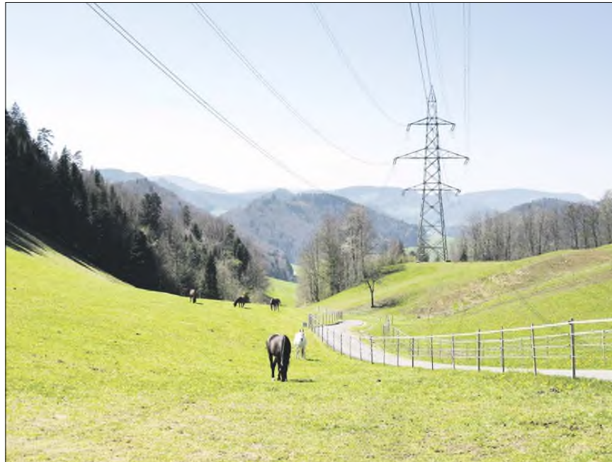
Stromleitungen, die über eine landwirtschaftliche Parzelle führen, können ein Hindernis sein. (Bild Josef Scherrer)
