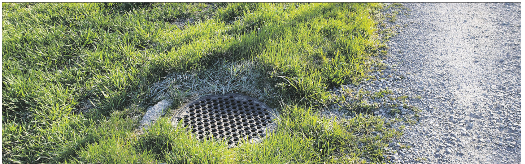
Um einen Entwässerungsschacht muss ein bewachsener Pufferstreifen von mindestens 0,5 Metern ab Schachtrand angelegt werden.
